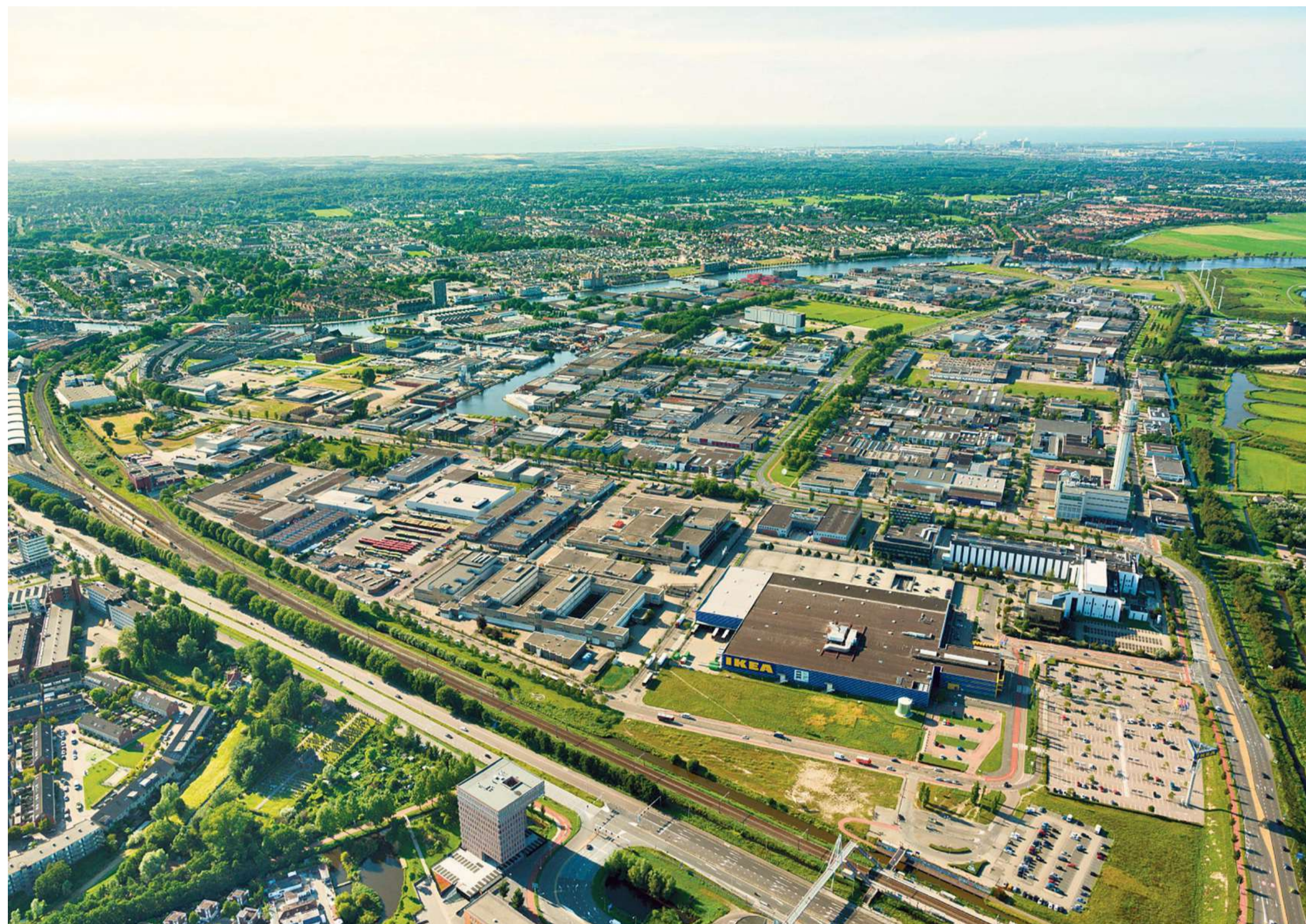
Industrieterrein Waarderpolder, met datacenter Iron Mountain op de lijn tussen IKEA op de voorgrond en de Schoterbrug op de achtergrond, en grofweg halverwege het industrieterrein.
